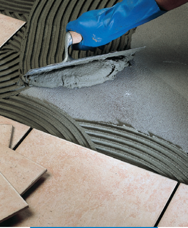
Τοποθέτηση μονόπυρου πλακιδίου σε δάπεδο
