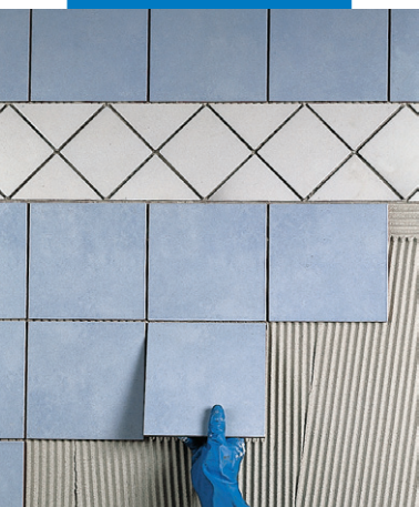
Τοποθέτηση μονόπυρου πλακιδίου σε τοίχο από γυψοσανίδα
